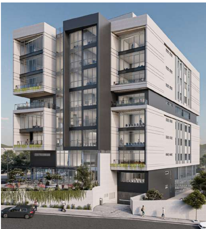
Imagen 55. Edificio de Ciencias de la Salud en PUCE Ambato
